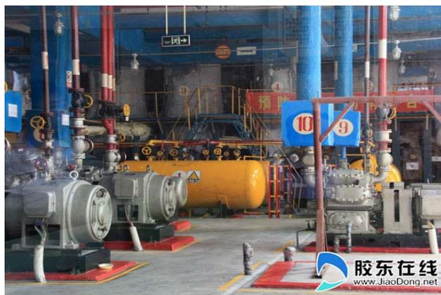
图 21：氨制冷用压力容器压力管道
