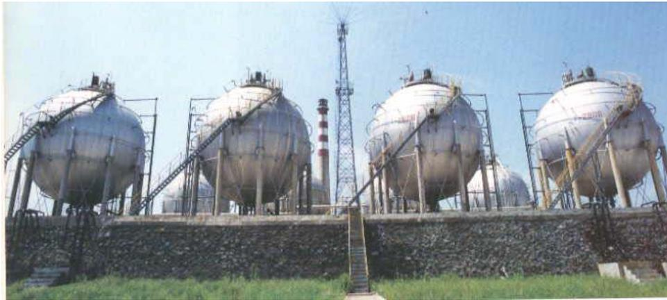
图 6：固定式压力容器（球形储罐）
